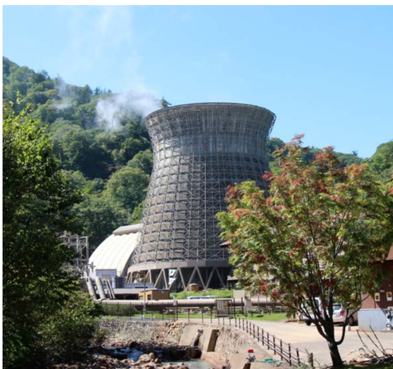
松川地熱発電所の外観(撮影:JOGMEC)
